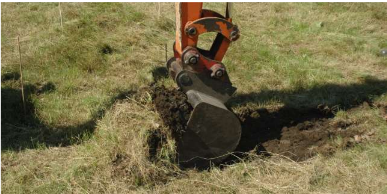
Versuchsflächen an der Lausche (DiverGrass Projekt) – Mähgutübertrag mit verschiedenen Oberflächenstörungen, einschließlich Oberbodenabtrag.
